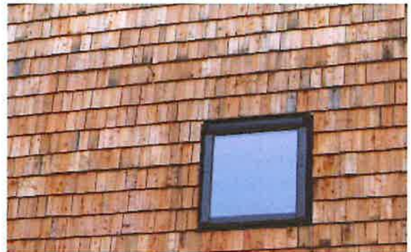
Exemple de bardage bois (en écailles) en façade G.Studio - Strasbourg
