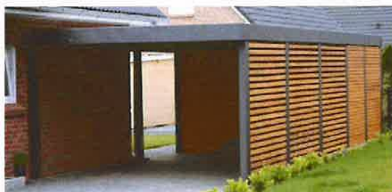
Carport à structure métal / remplissage bois
