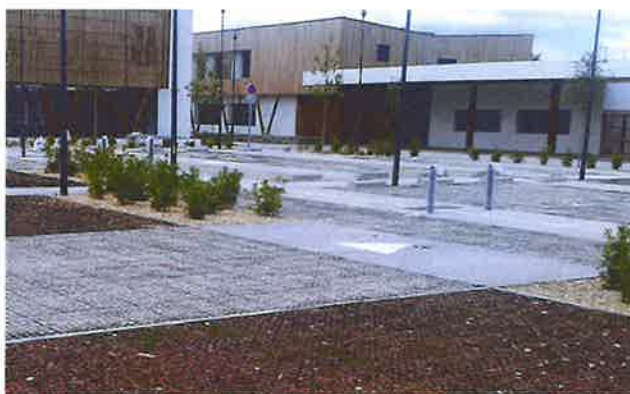
Exemples de dalles alvéolées : en béton avec engazonnement (à gauche), en plastique avec gravillons (à droite)
